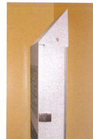
▲施工例 / 制御盤用傾斜カバー
