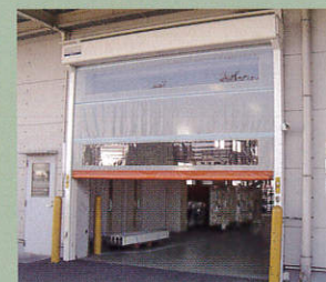
▲施工例(メーカー工場)
